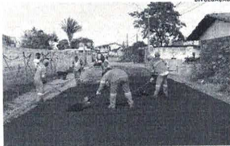
Operários da Semosp trabalham na pavimentação de ruas e avenidas da capital maranhense
